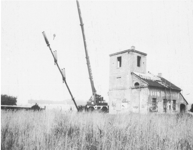
Aufsetzen des Signalmastes, 1970 (Bild 6)
